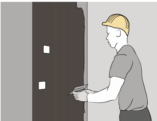
Application de la colle sur enduit
