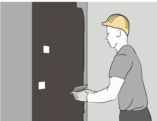
Extender el adhesivo sobre el revoque
