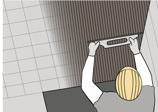
Extender adhesivo en el sustrato existente
