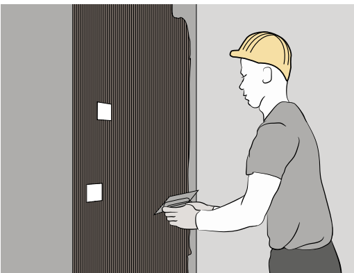
Extender el adhesivo sobre el revoque
